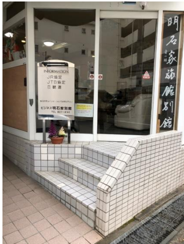
入口自動ドア。3段の階段。 フロント
