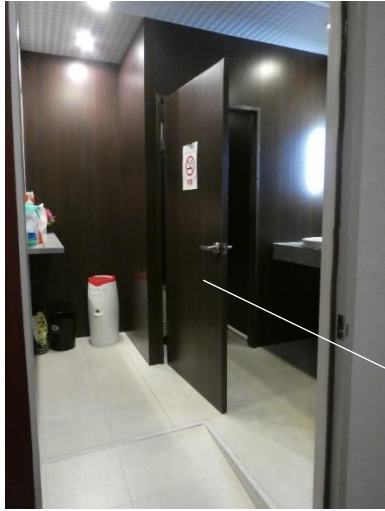
共用トイレ（2階）
