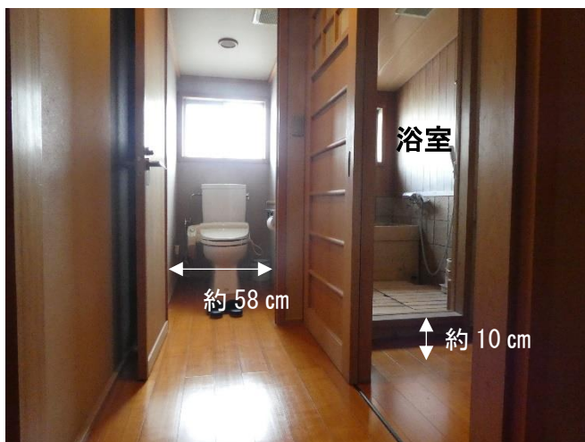
トイレ。間口約 58 cm。壁面にL字型手すりあり。
