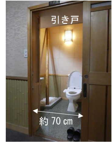
2階共用トイレ
