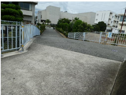
⑨ 急な下り勾配のある道路を北へ約 50m
