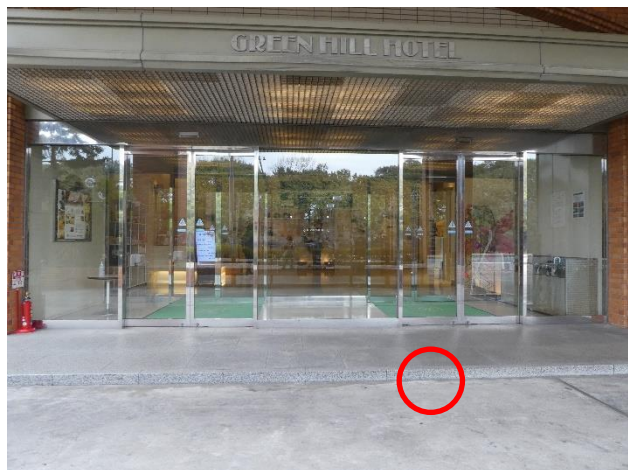
エントランス。約 10 cmの段差あり。 一部スロープ状
