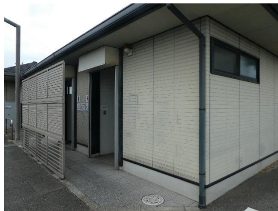
駐車場内の障がい者用トイレ
