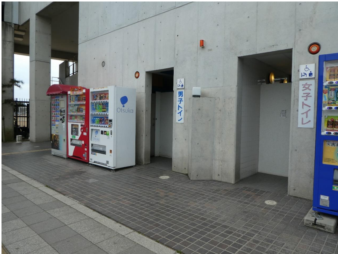
大蔵海岸（東側）歩道橋下のトイレ
