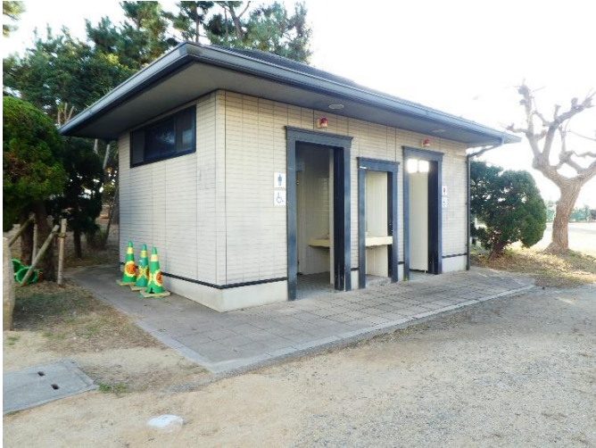
大蔵海岸（西側）最西端の入口付近のトイレ
