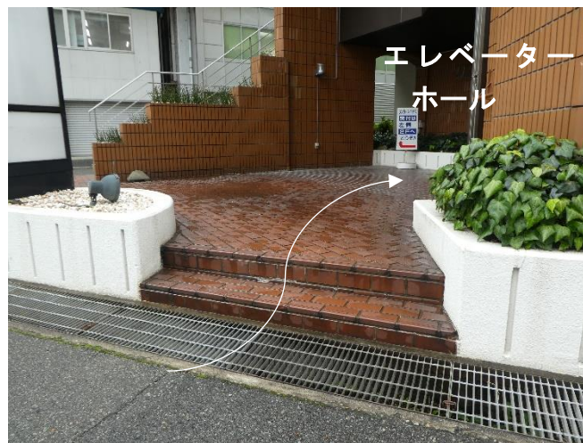
エレベーターホールの前に段差とグレーチングあり
