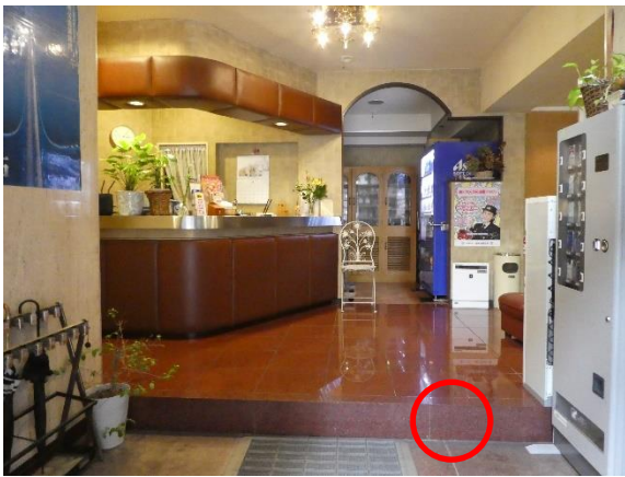
エントランス。 約 20 cmの段差。
